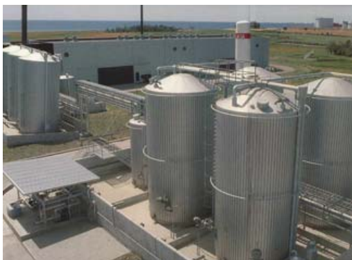
Bild 2: Behälter für die Mischung des PVC-Abfalls mit Lauge und Wasser
