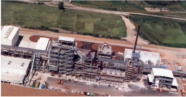
Bild 5: Drehrohrofenverwertungsanlage bei DOW in Schkopau
